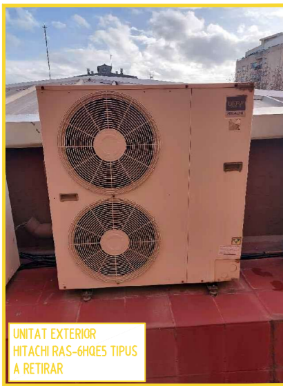
UNITAT EXTERIOR HITACHI RAS-8HQES TIPUS A RETIRAR
